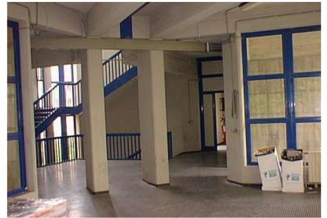
Nuovo Conventino – dettaglio interno
