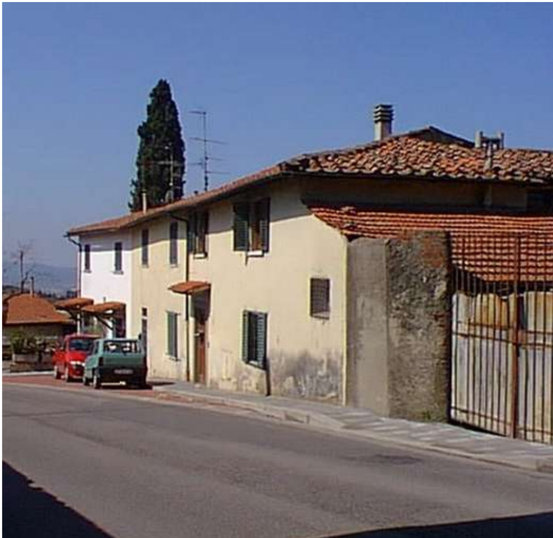
Appartamenti Via Bolognese – vista facciata
