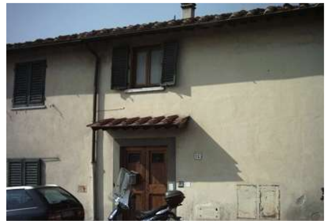
Appartamenti Via Bolognese – dettaglio facciata
